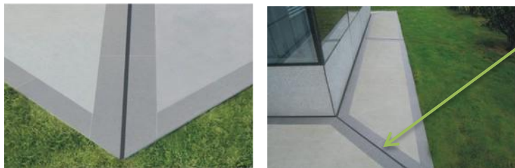
散水断缝设置
