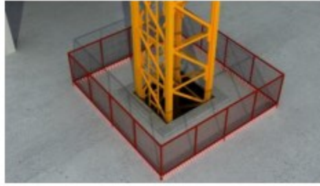
预埋式塔吊基础周边围栏示意图
