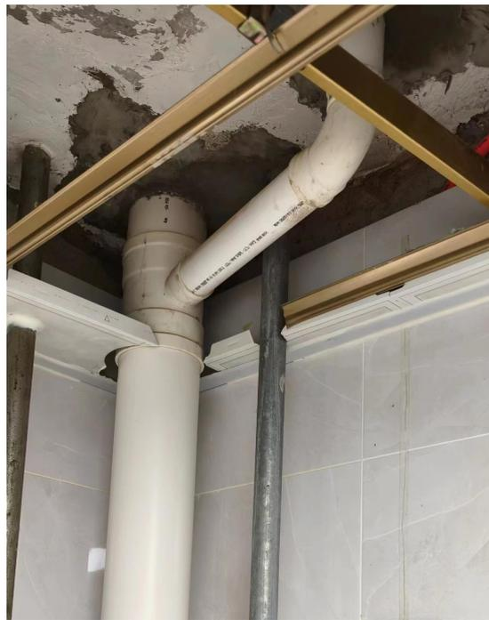
PVC-U 排水管安装和吊顶恢复
