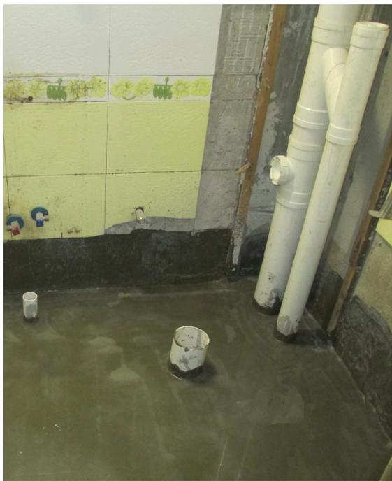
PVC-U 排水管安装和卫生间地面防水施工
