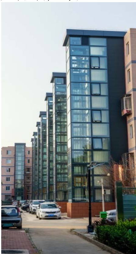
加装电梯典型工程照片(半层入户)
