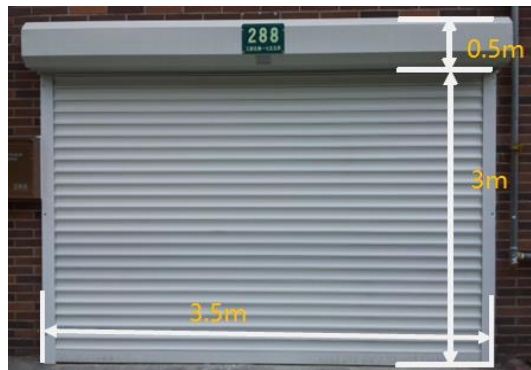
图 4-1 卷帘门尺寸计算示意图
