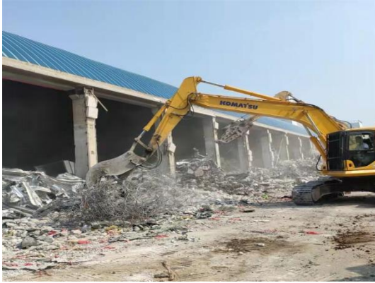
先拆除非承重结构示例图
