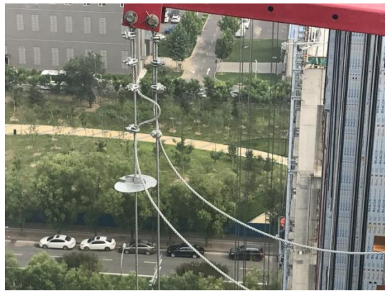
超高限位器止挡板安装示意图
