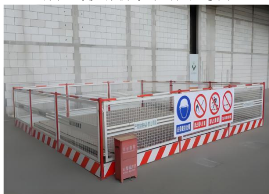
1.5m 以上洞口防护示意图
