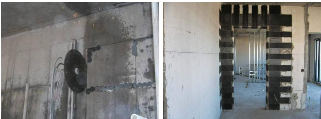
墙体开洞切割示例图
