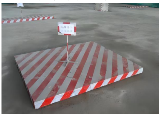
1500mm 以下洞口防护示意图
