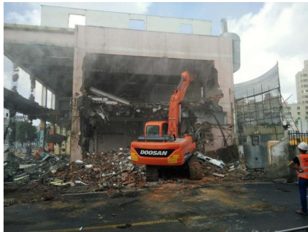
拆除旁站监督防交叉作业示例图
