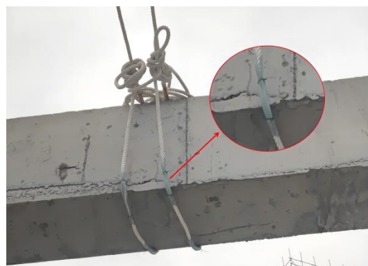
工作绳固定及防剪切措施示例图
