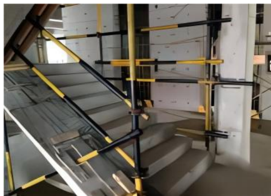
钢管式楼梯防护栏杆示意图
