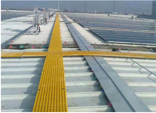
轻质型材屋面临时走道板示例图
