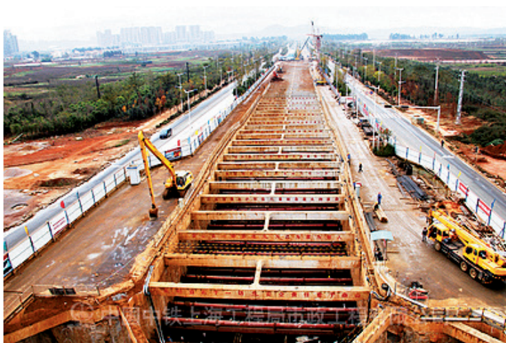
图7-10 地铁车站盖挖逆操作施工实例
