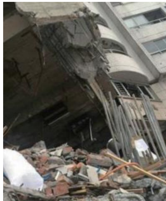
图1.2 钢筋断裂（来源：海外网）
