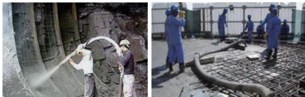
(a) 喷射混凝土
