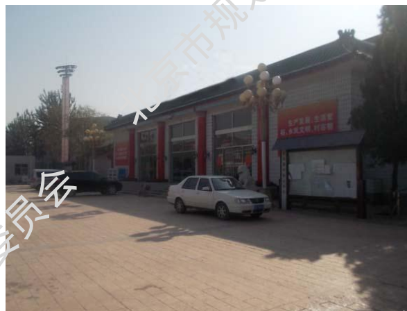
图11 公共建筑广场前停车
