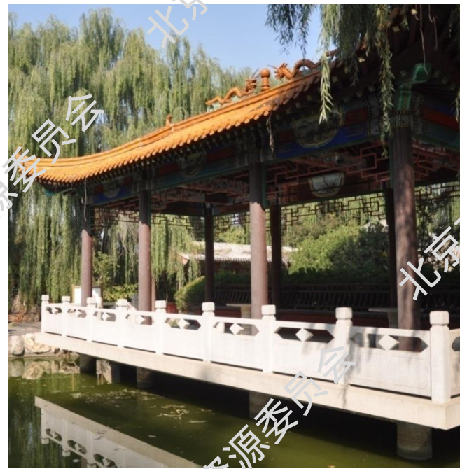
图43 休憩亭廊实例
