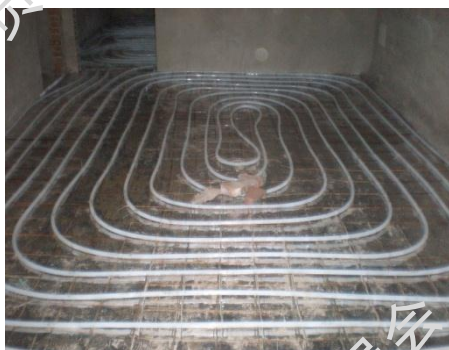
图12 地板采暖系统管路铺设
