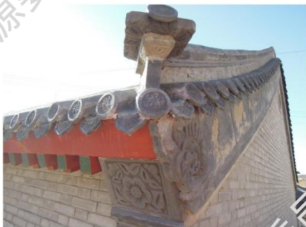
① 筒板瓦屋面檐口正立面
