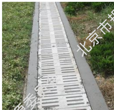
图6 预制混凝土排水沟
