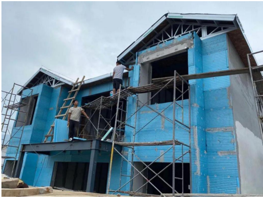
图 2-6 钢结构屋架及屋面保温、防水安装
