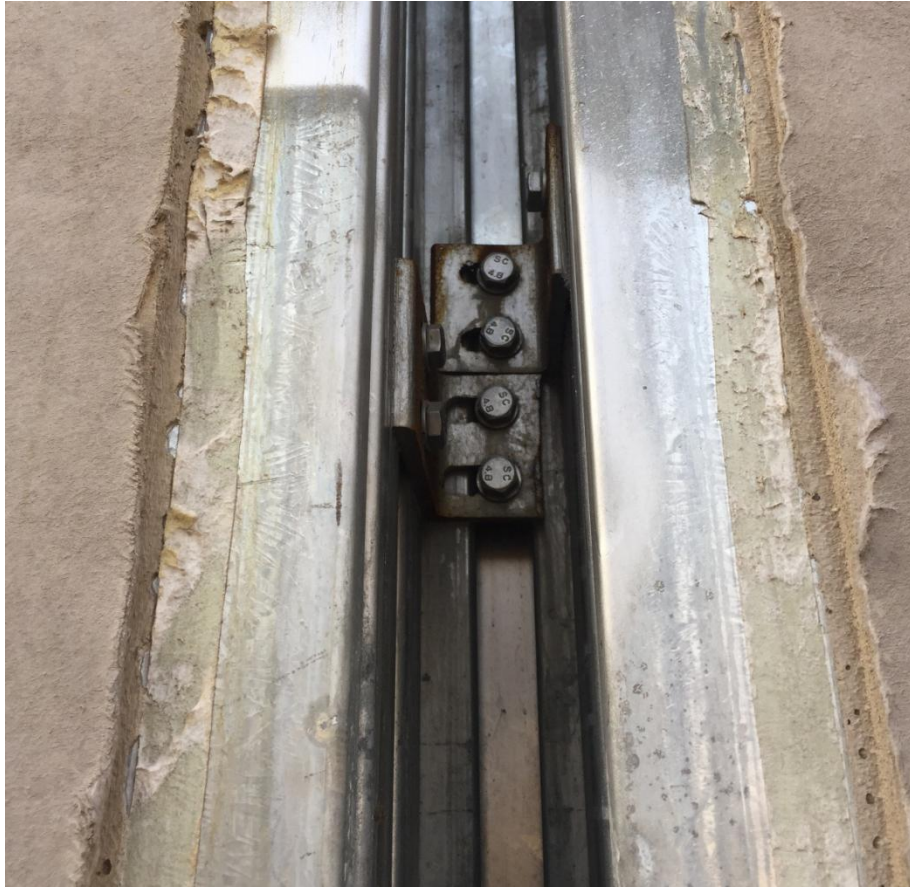
图2-18 某发泡水泥复合板结构板间螺栓连接图片
