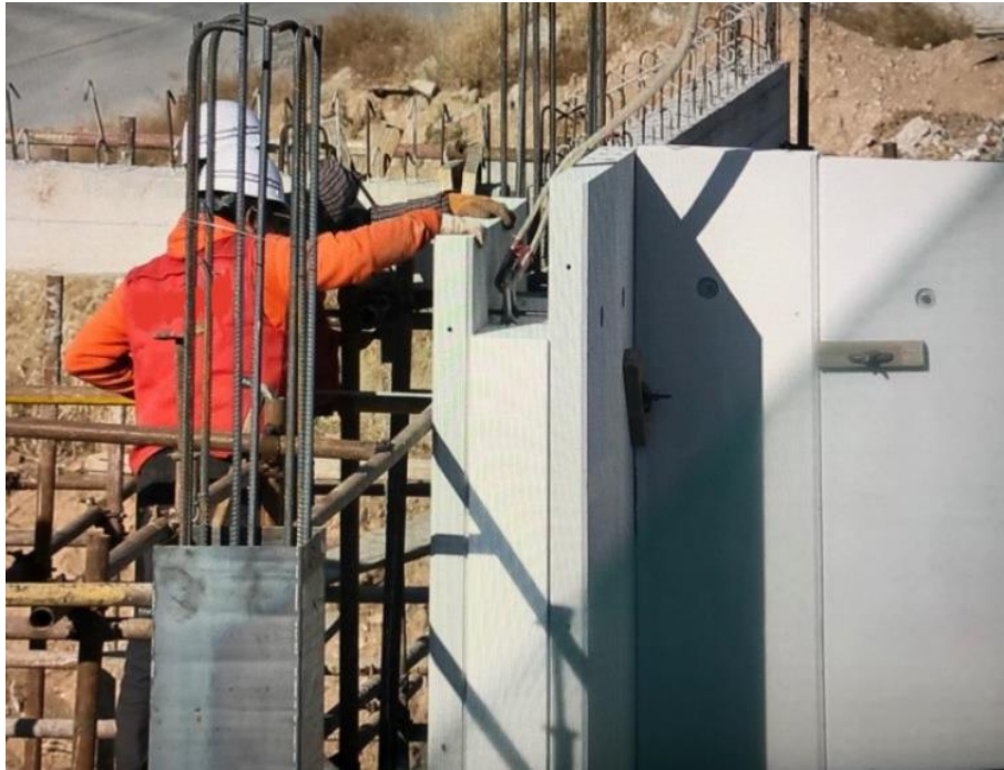
图 2-33 装配式框架结构房屋预制带凹槽外墙条板安装
