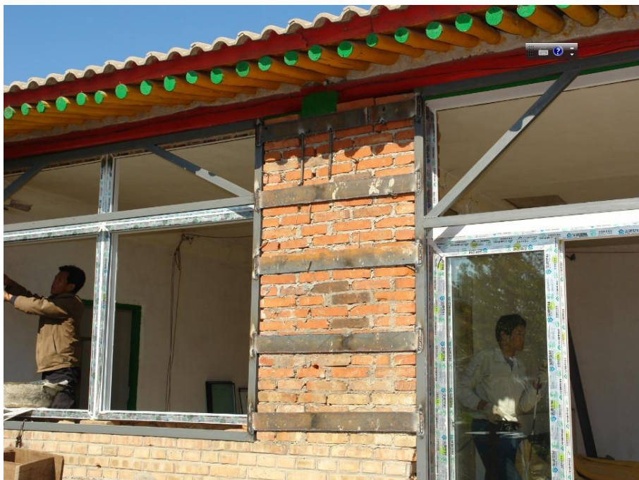
图 5-10 门窗洞口边用槽钢镶边加固（施工中）
