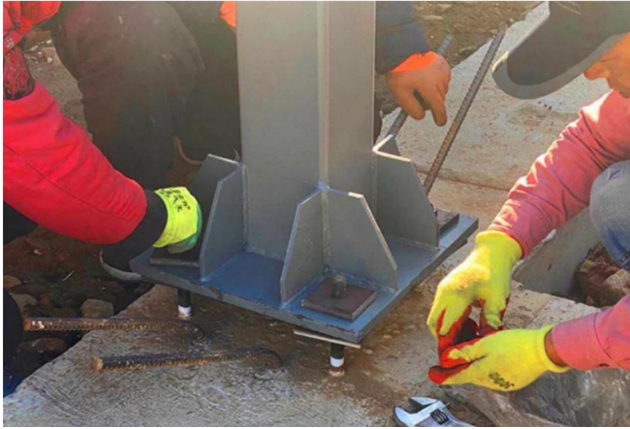
图 2-2 钢柱定位（柱脚宜采用灌浆料填充）
