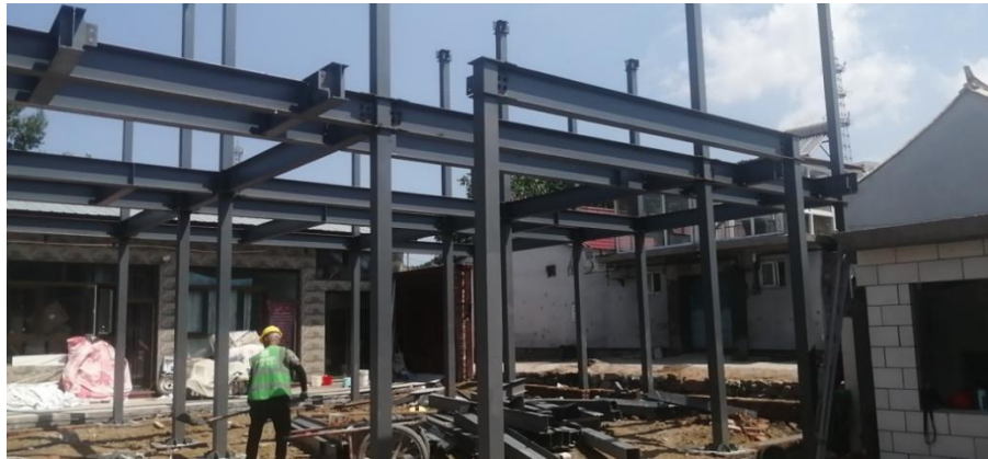
图 2-3 钢框架梁安装
