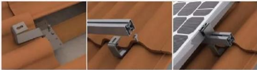
图 6-13 顺坡架空设置光伏组件
