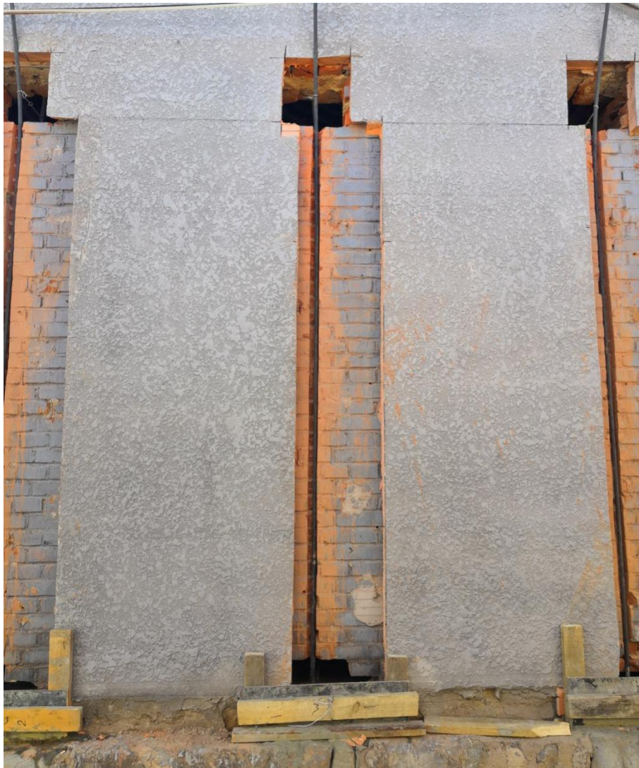
图 5-14 布置预应力筋并浇筑锚固端混凝土垫块
