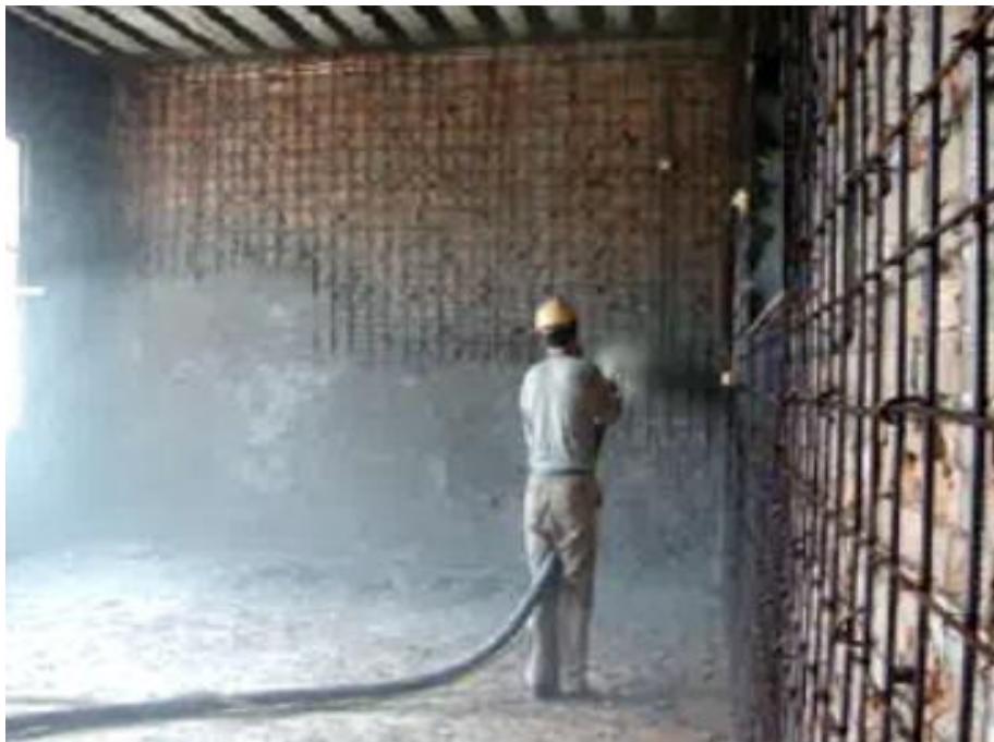
图5-8 挂网喷射混凝土板墙加固墙体实例
