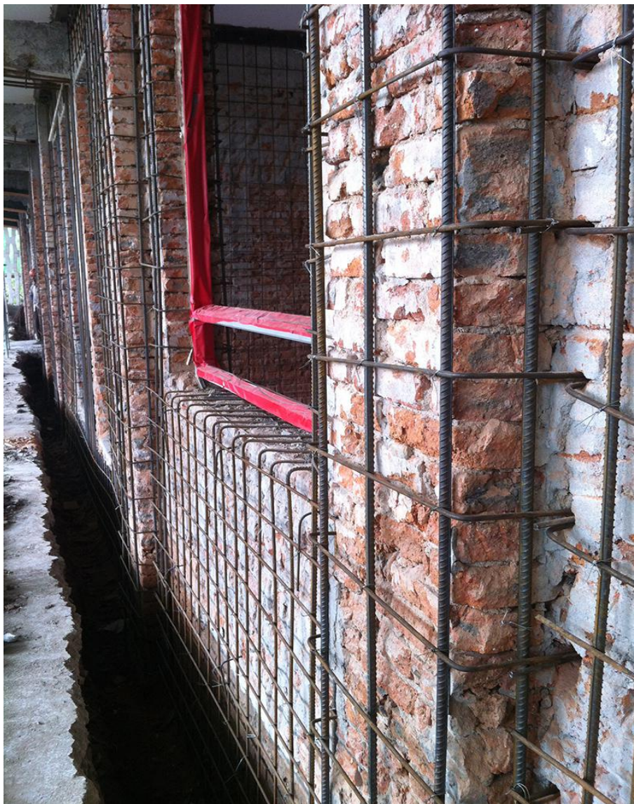
图 5-21 双面钢筋混凝土板墙加固
