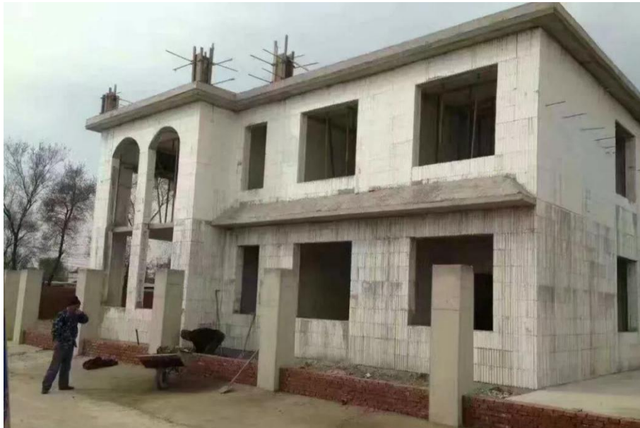
图 2-53 某二层聚苯模块剪力墙结构竣工效果
