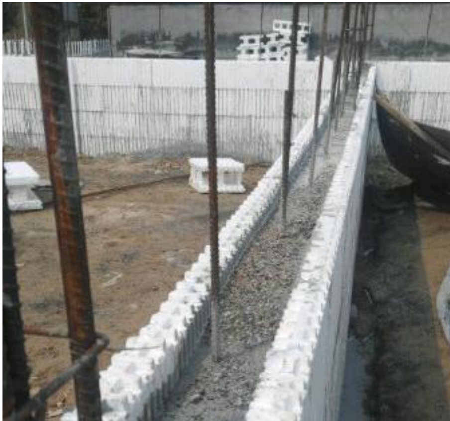
图 2-52 聚苯模块空腔混凝土墙体分层浇筑
