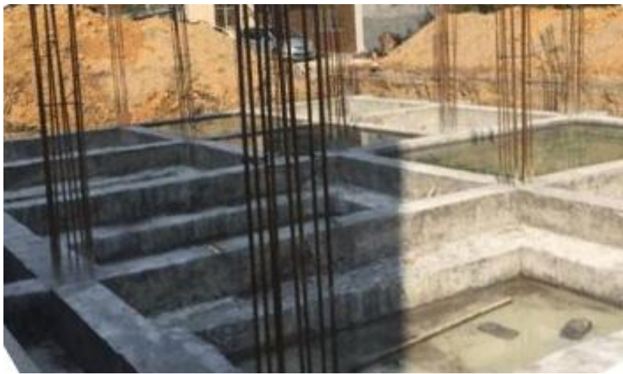
图 2-31 框架柱下条形基础完工
