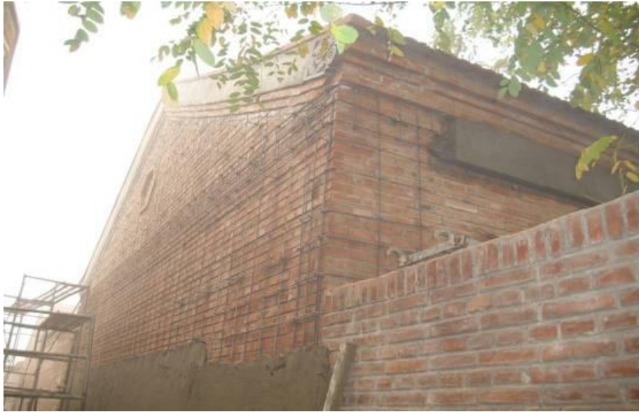
图5-7 钢丝网砂浆面层加固墙体实例
