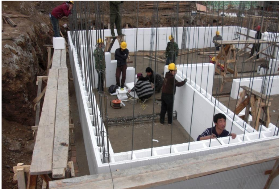
图 2-48 聚苯空腔模块错缝插接拼装
