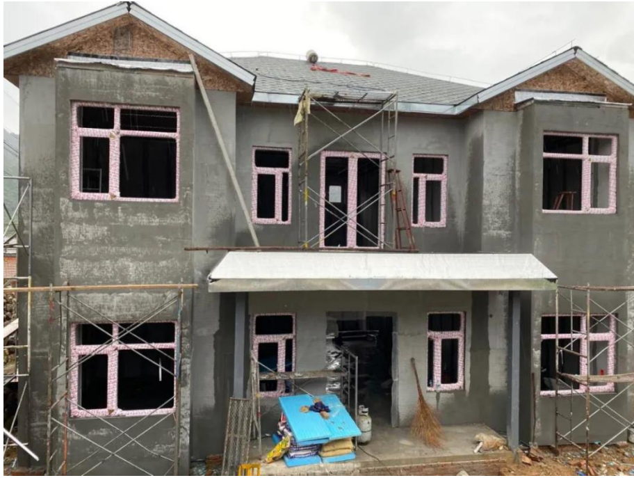
图 2-7 钢结构外墙保温及防护层施工
