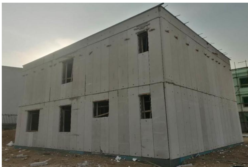
图 2-37 主体结构（含外围护墙）施工完毕（西北立面）
