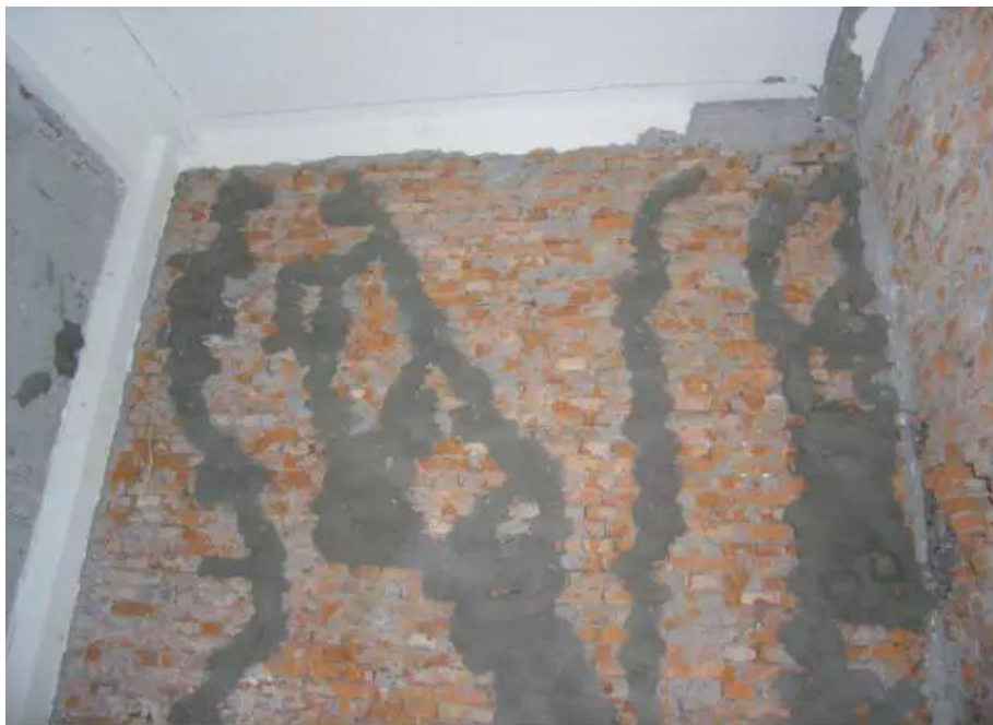
图5-4 某震后砌体墙裂缝修复（灌浆加固）实例
