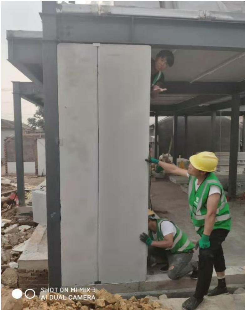
图 2-5 钢结构围护墙板及隔墙板定位、固定
