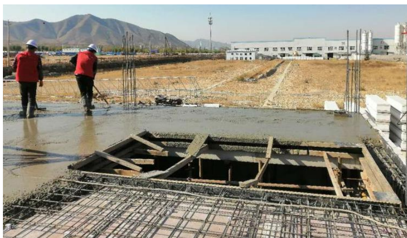
图 2-35 叠合梁、叠合楼板、柱浇筑施工
