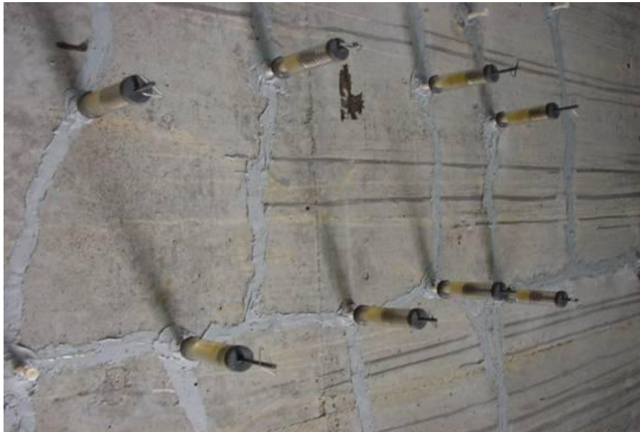
图5-5 墙体局部灌浆加固示意（此处为混凝土墙）
