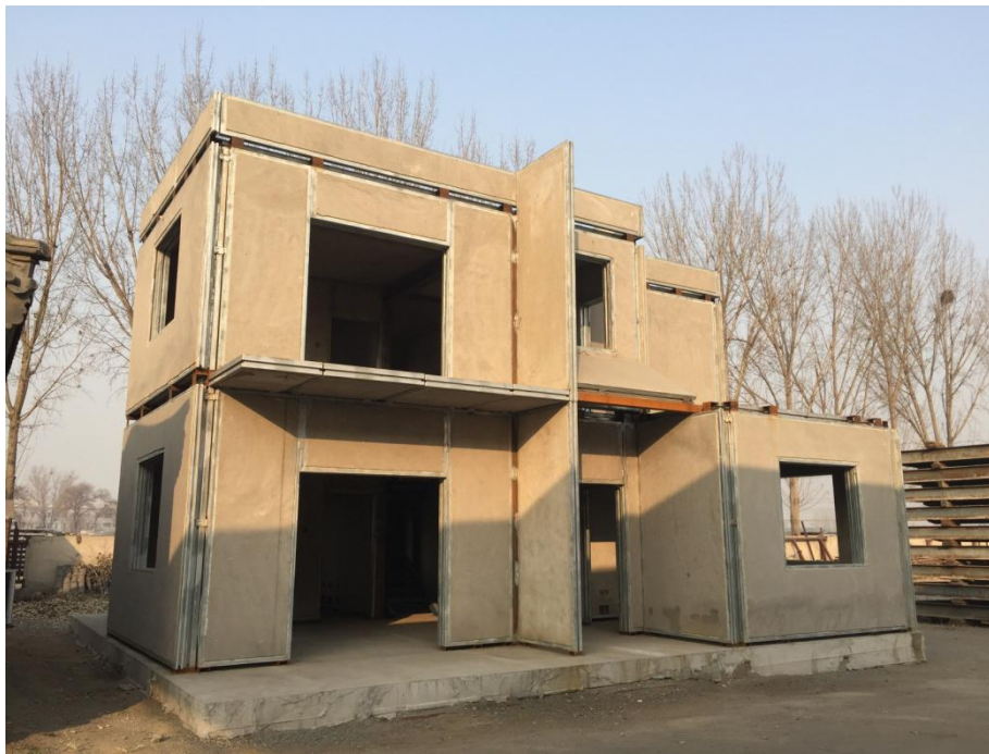
图2-17 某二层发泡水泥复合板结构房屋板材拼装完毕后图片
