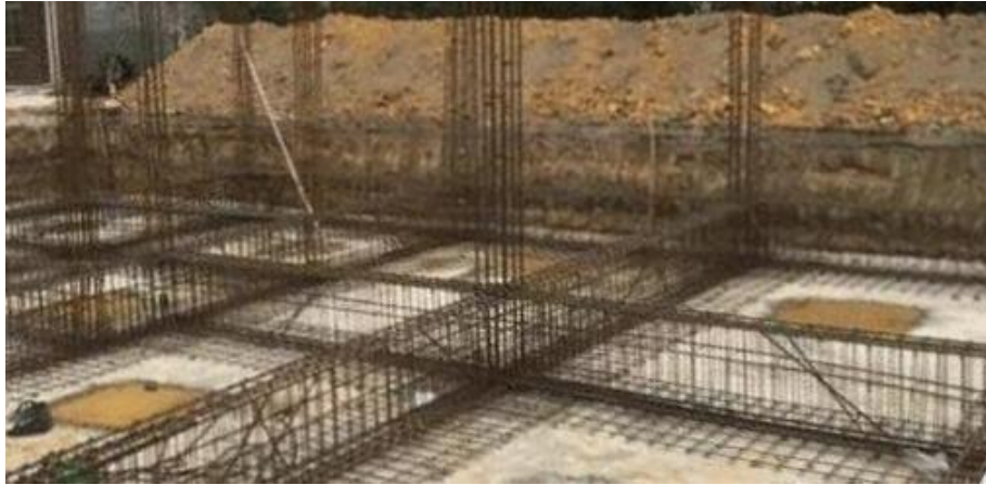
图 2-30 框架柱下条形基础（基础梁、板）钢筋安装
