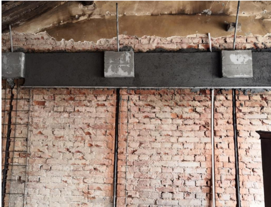
图 5-15 浇筑张拉端垫块
