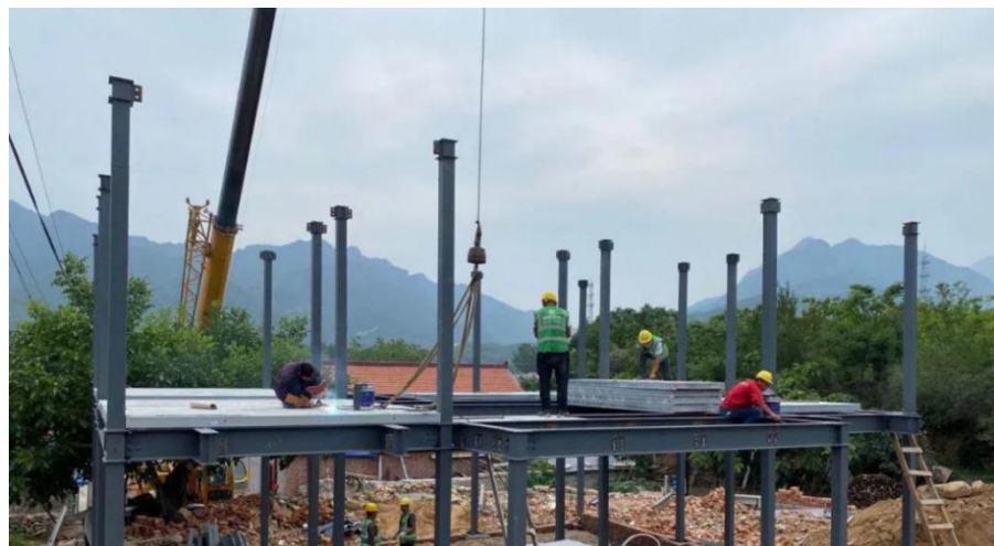
图 2-4 带钢框轻质楼板安装
