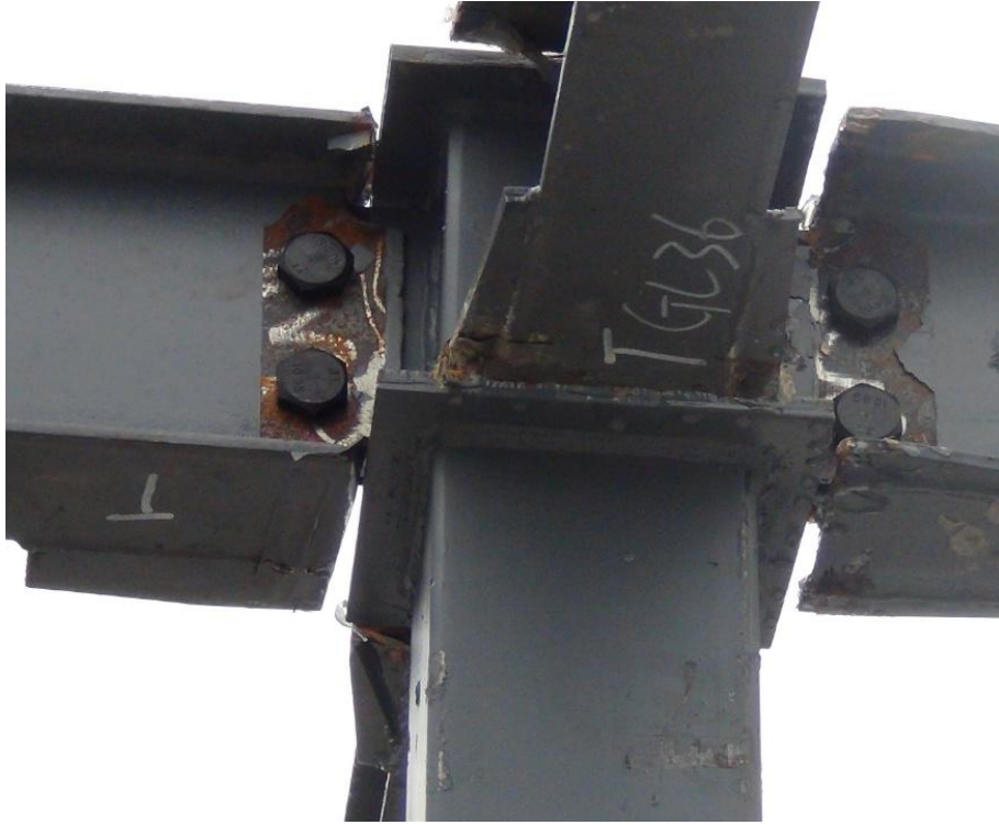
图 2-9 钢梁、柱连接节点（施焊前）
