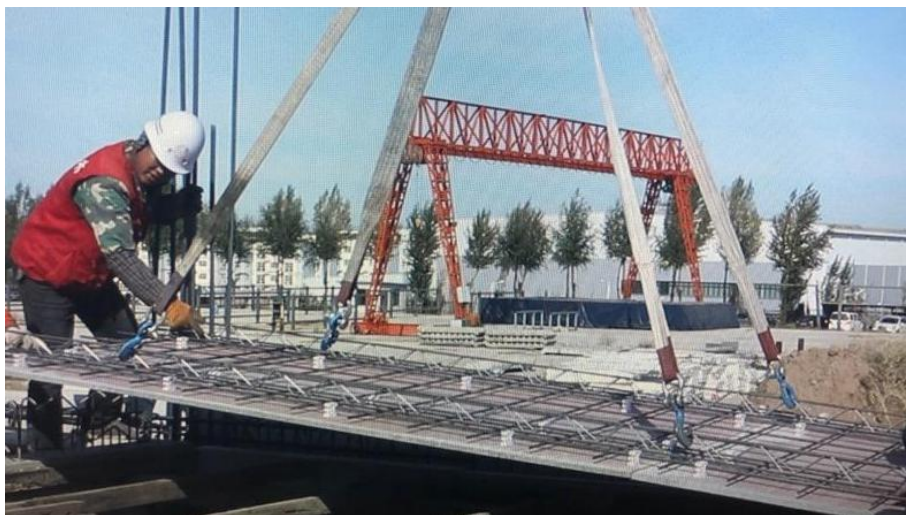
图 2-34 预制叠合板吊装就位
