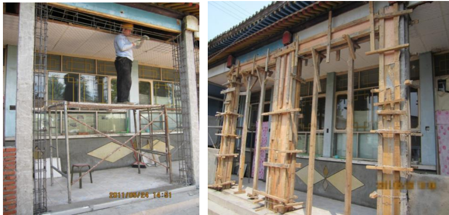
图 5-11 墙角用角钢及钢板包角加固
