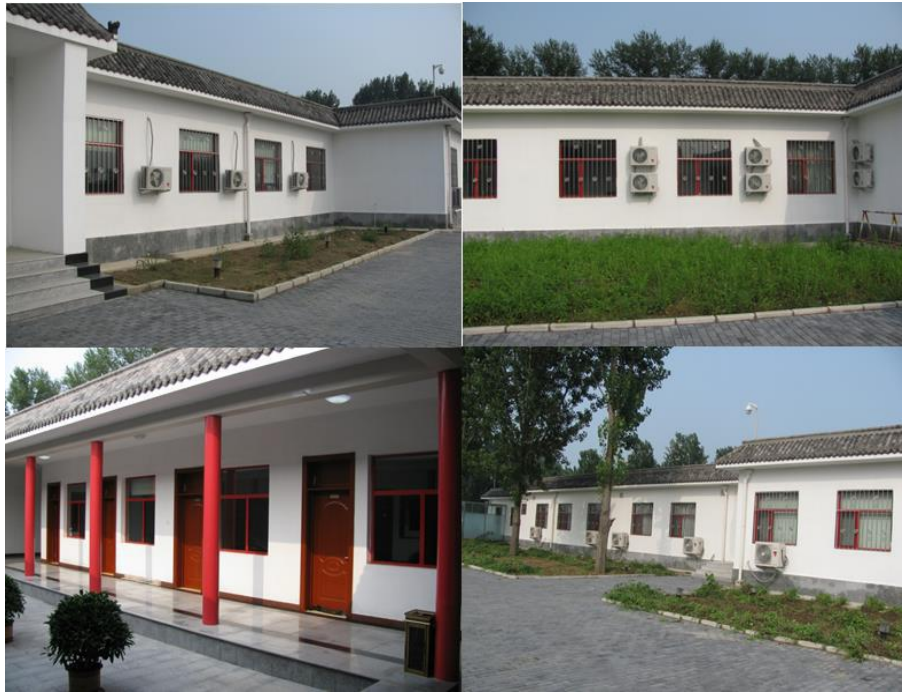
图2-20 某单层发泡水泥复合板结构房屋实例
