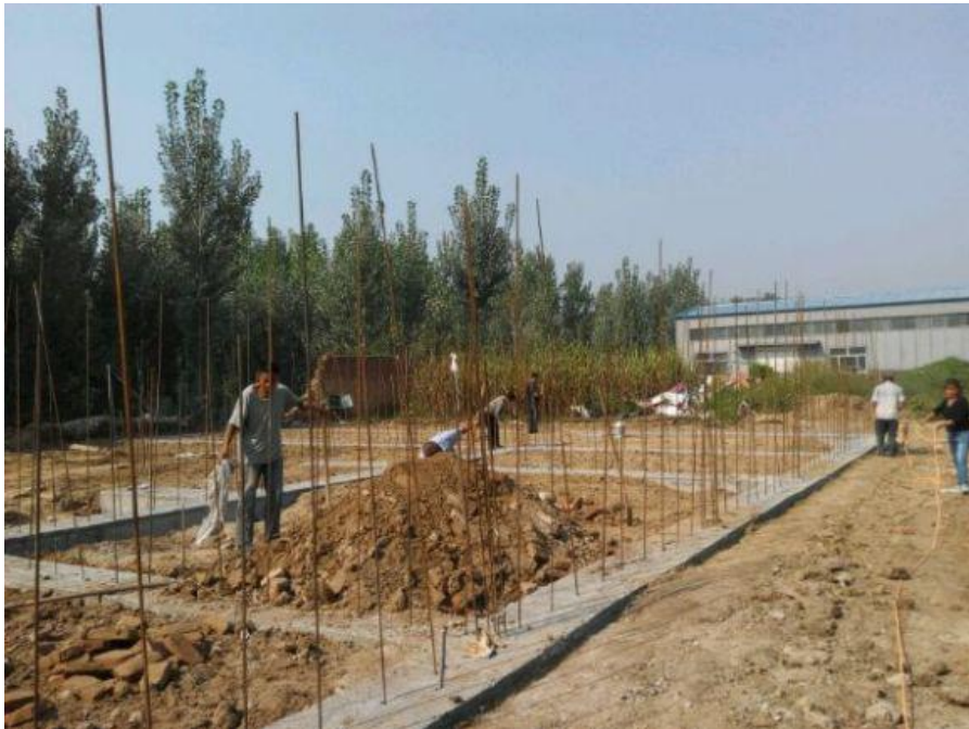
图 2-51 墙下条形基础（含插筋）
