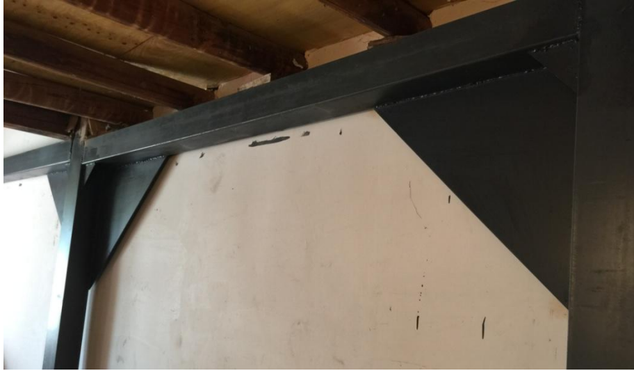
图 5-19 增设钢托梁加固
