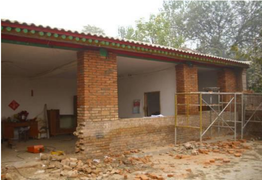
图5-3 前纵墙位置增砌抗震墙
