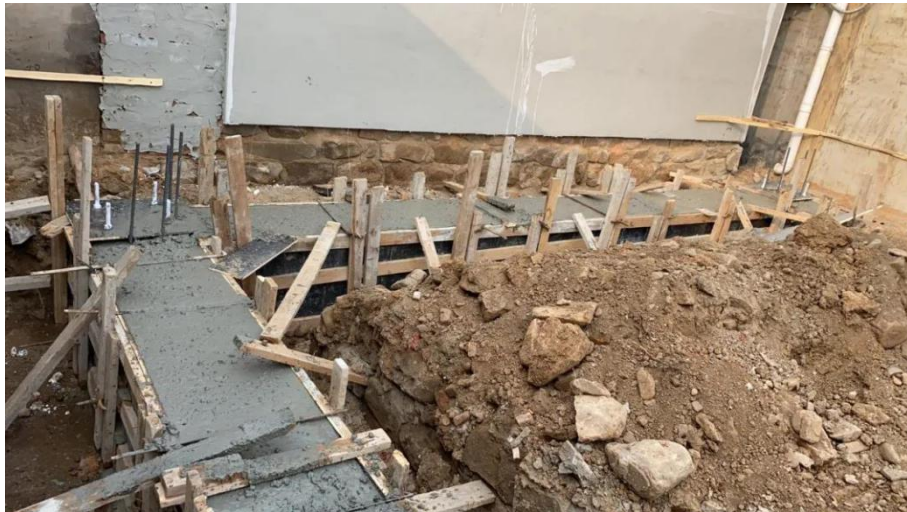
图 2-1 柱下条形钢筋混凝土基础施工
