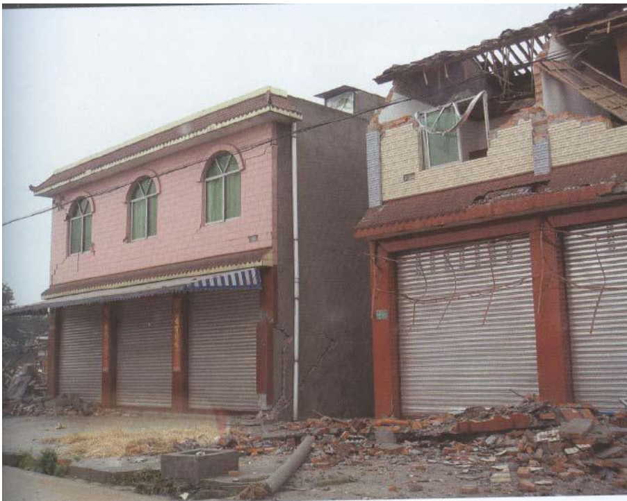
图 3-4 某地区相邻建筑震害对比
