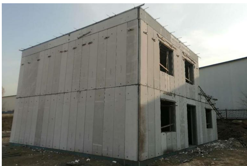
图 2-36 主体结构（含外围护墙）施工完毕（西南立面）
