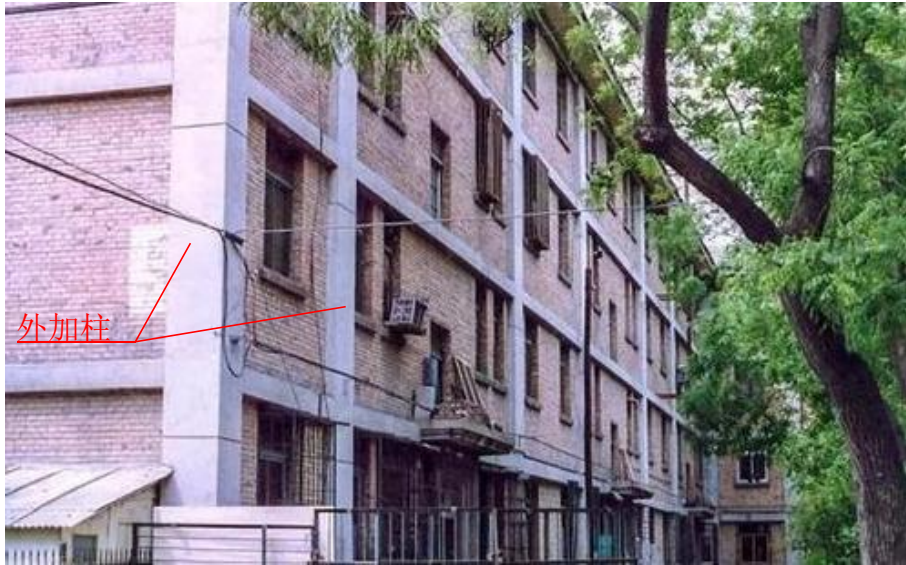
图5-9 外加柱加固图
