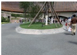
图4 中国馆室外胶粘土防滑路
