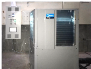
图2 热泵机组及其变频控制柜
