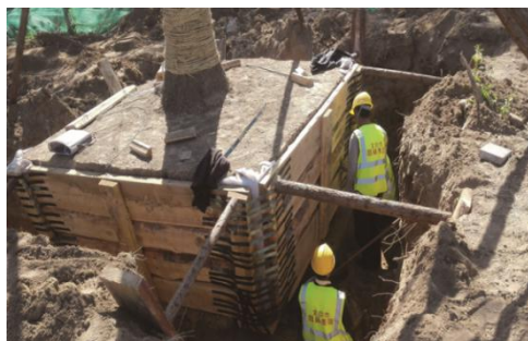
掏底、上底板 箱板紧固
