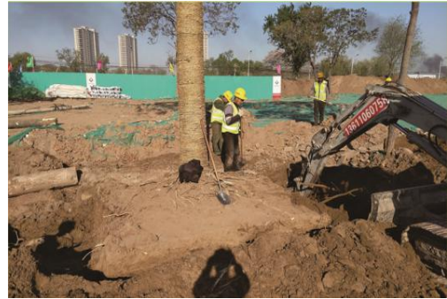
土台挖掘挖土
