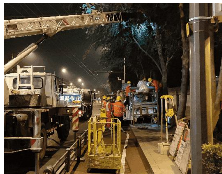
翻转作业-翻转头入井
