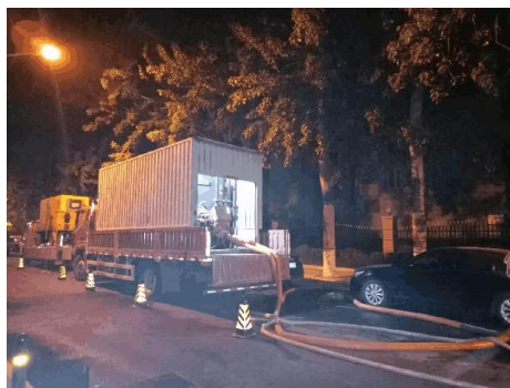
翻转作业-车载锅炉加热固化
