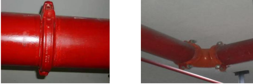
图 1-4 沟槽管件示意图
