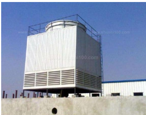
图 1-6 配一台电机冷却塔
