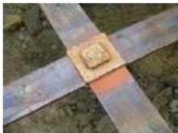
图 9-1 放热焊连接
