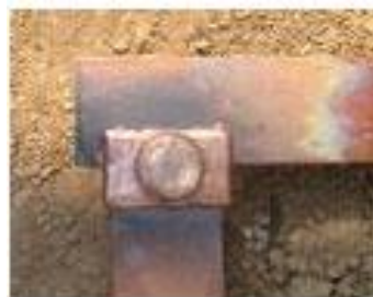
图 9-2 放热焊连接
