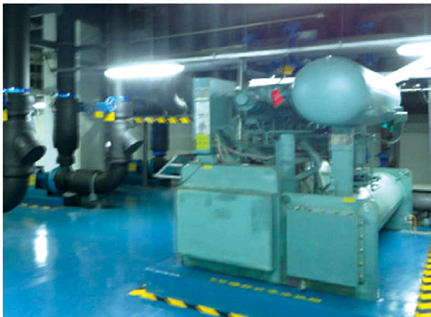
■ 螺杆式制冷机组
