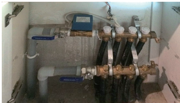
图4 户内分集水器实景照片
