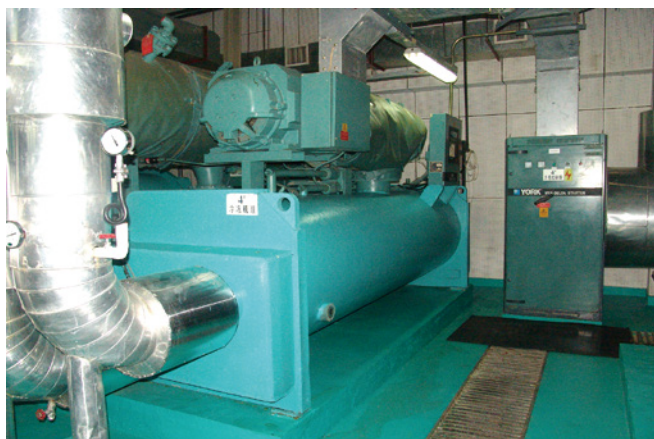
图2 制冷机组
