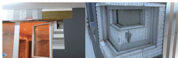
图 在水一方项目外维护结构施工工艺
