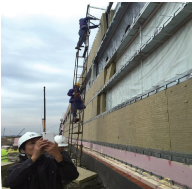
图 森鹰被动式工厂外墙保温结构
