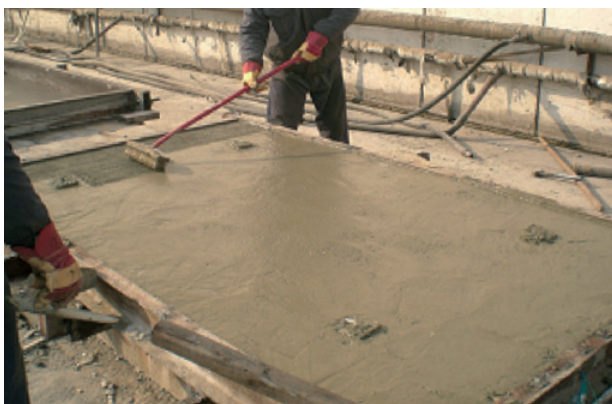
图 硬装地面混凝土浇筑
