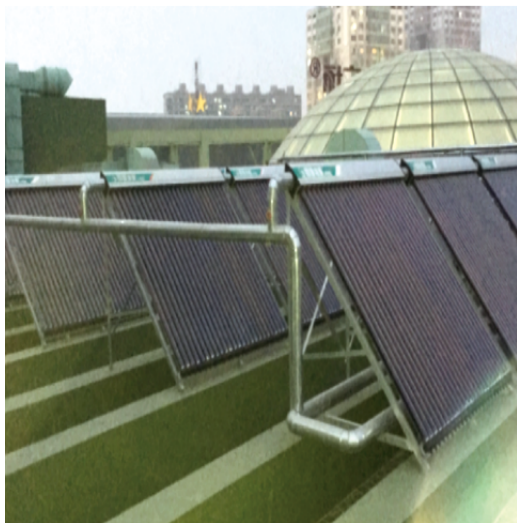
图4 太阳能热水系统实景图
