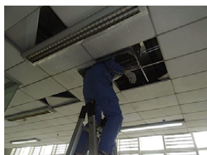
图 30 空调末端系统设备检修
