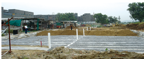
图 20 毛管渗滤处理装置安装
