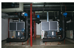
图10 地源热泵机组
