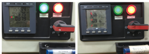
图4 三甲医院A锅炉房换热器和锅炉房地下一层生活水泵计量表
