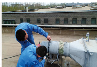
图 31 楼顶排风机组维护保养
