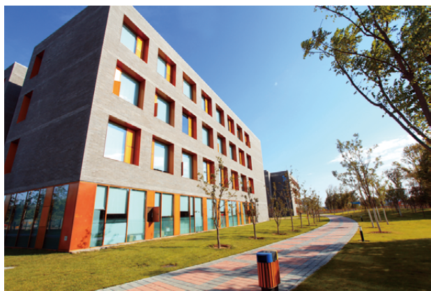
图8 节能清水混凝土砌块外墙和铝合金窗
