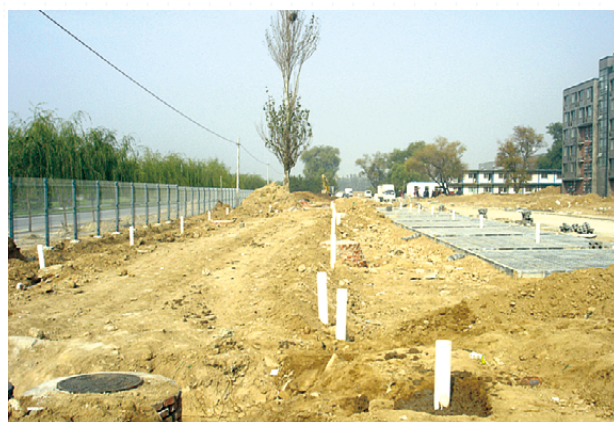
图 21 毛管渗滤处理装置回填
